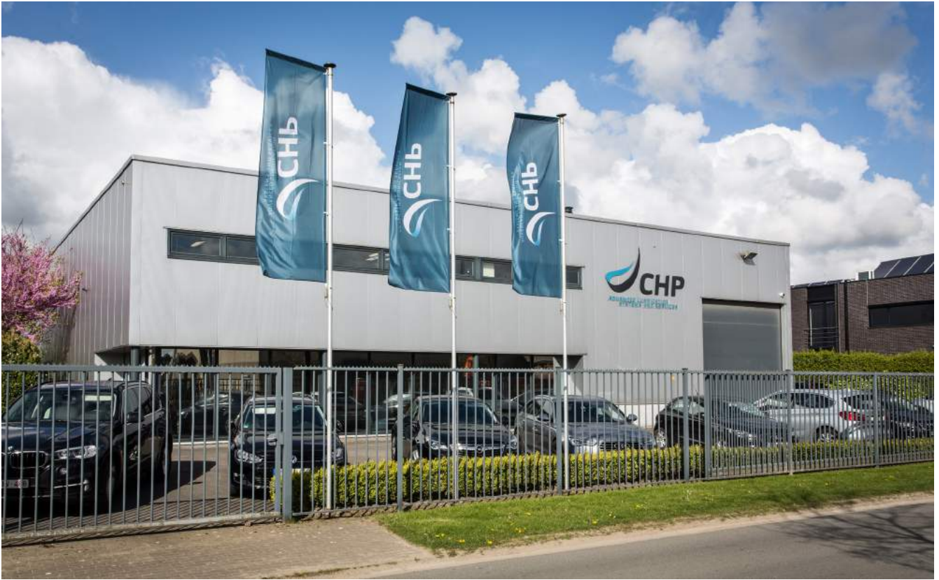
CHP uit Beveren bouwt geautomatiseerde systemen voor de droge smering van transportkettingen.
